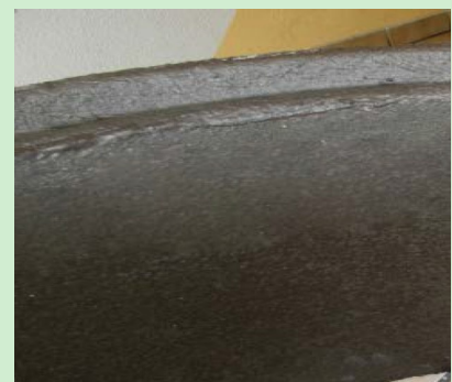
Beschichtung eines Behälterteiles zur Silageeinlagerung.
