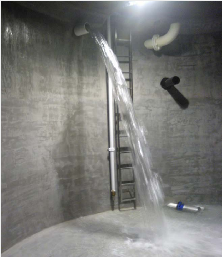
Fig. 8 Innenansicht nach der Sanierung Franz. Legende
