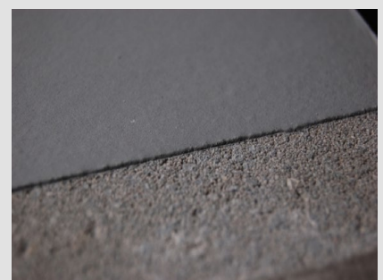
Auftrag in 1-3 mm Schichtstärke
